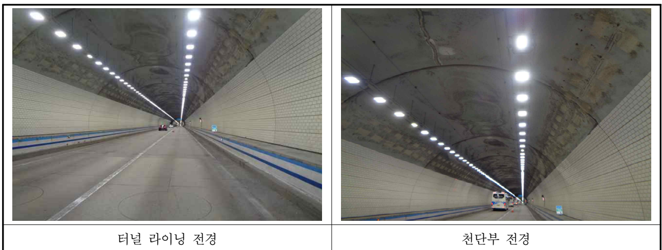
【사진 3.3】 터널 라이닝 천단부 전경
