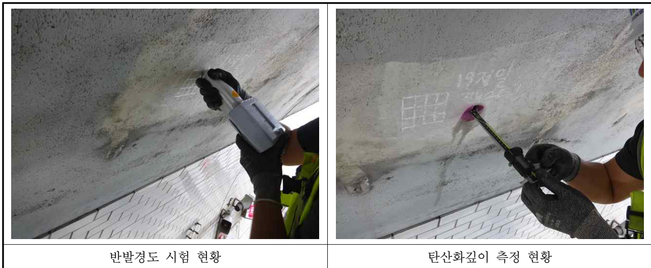
【사진 3.16】 콘크리트 내구성조사 현황
