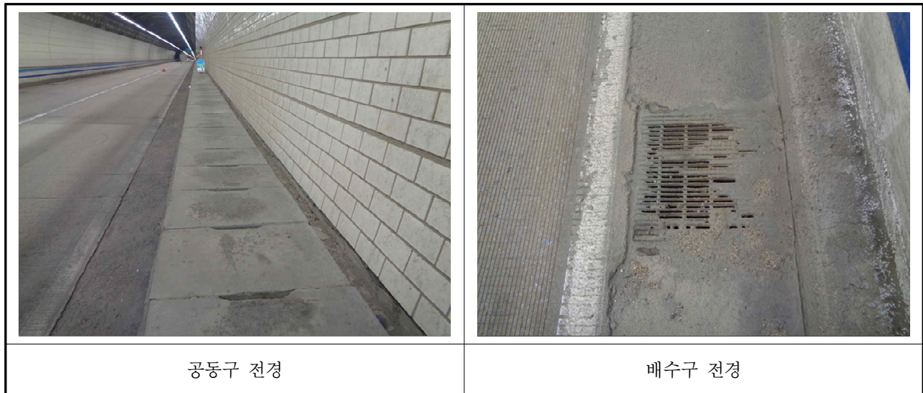
【사진 3.11】 공동구 및 측구(배수로) 전경
