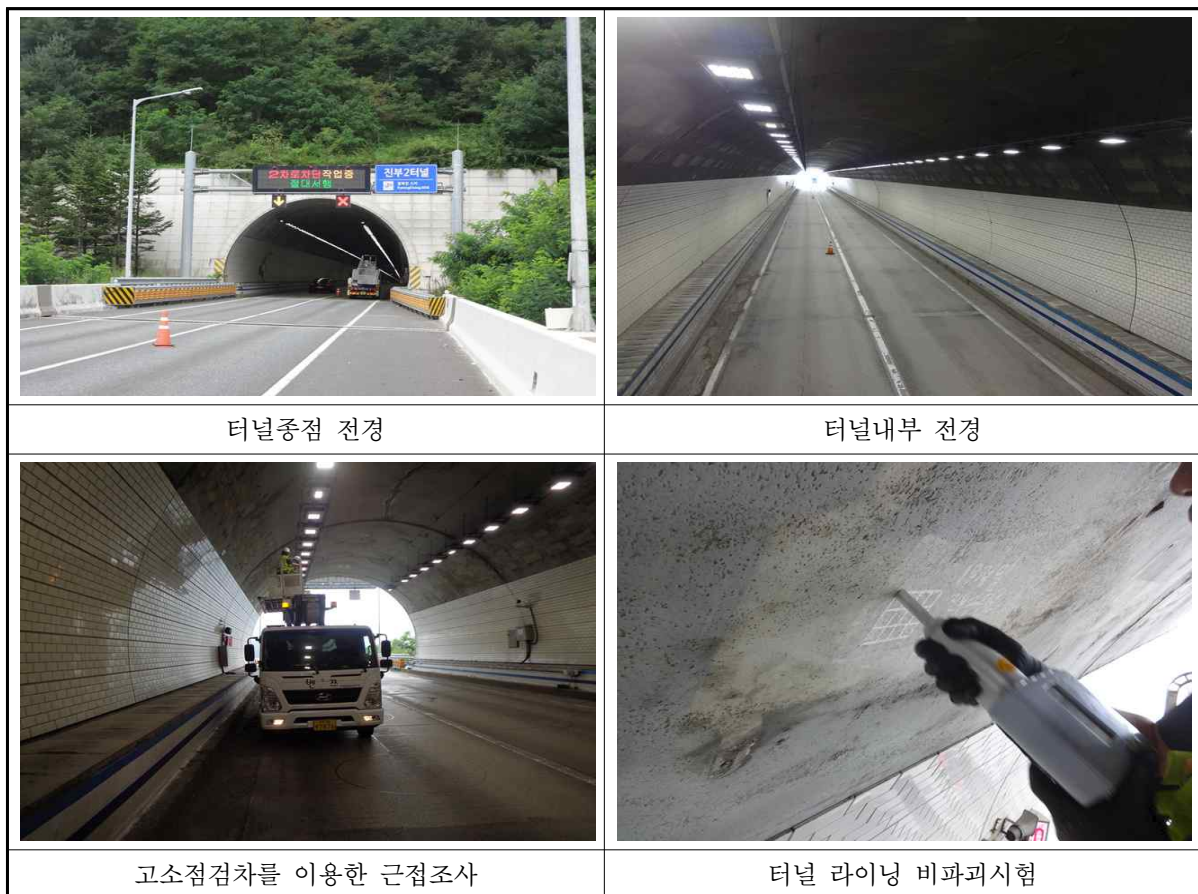
【사진 3.2】 근접조사를 위한 장비 사용 전경
