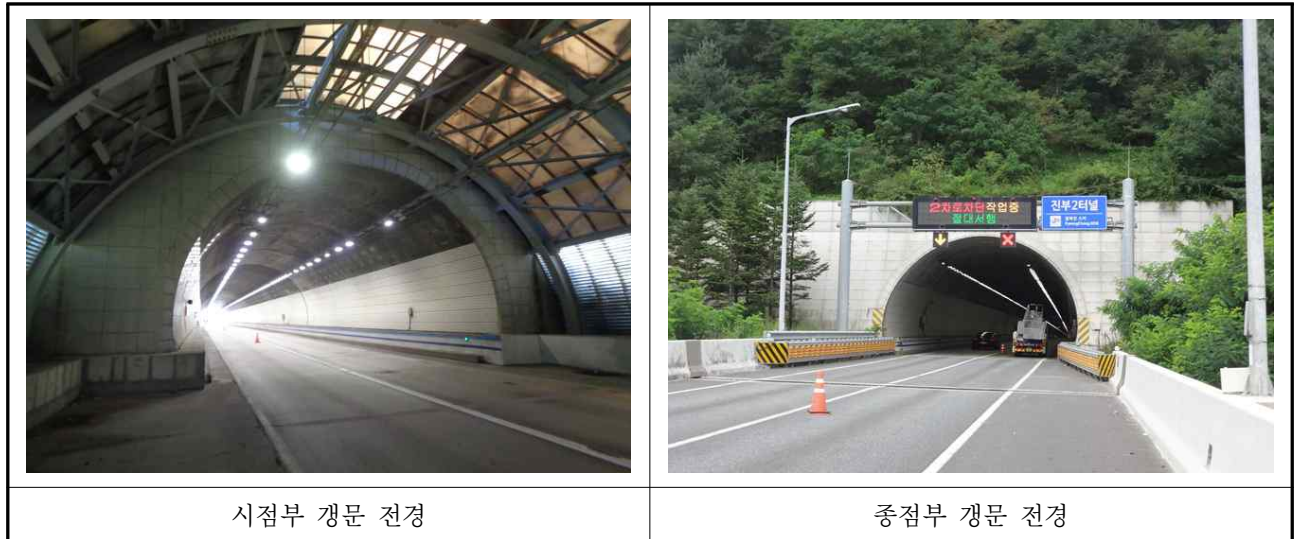
【사진 3.7】 갱문 시·중점부 전경
