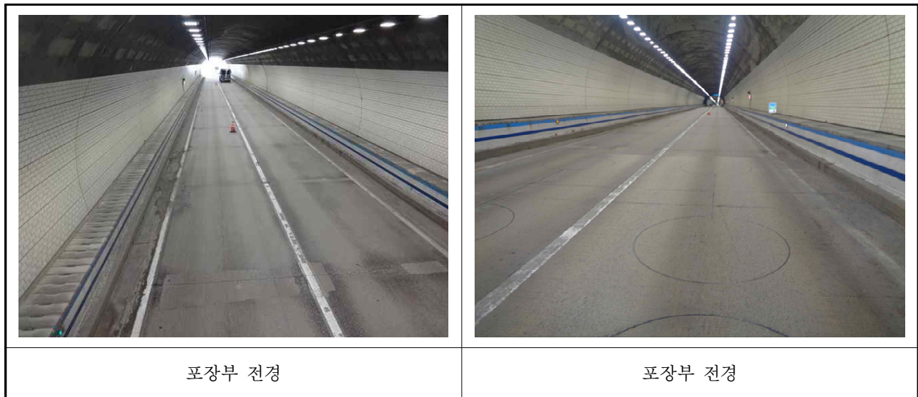
【사진 3.13】 터널 포장부 전경
